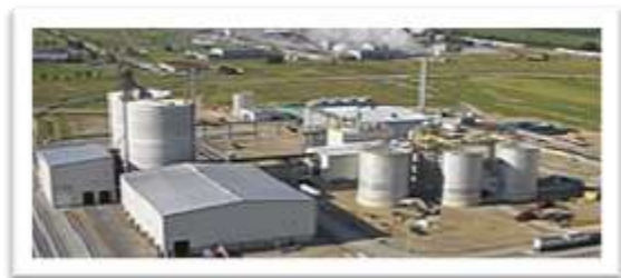
Завод по производству биодизеля 32 000 т
